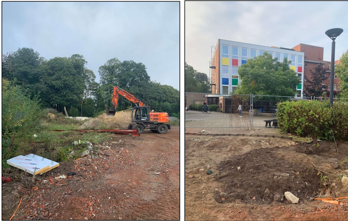
Figuur 9. Zicht op de zone van het talud voorafgaand aan het aanleggen van de sleuf (links) en de parking die vooralsnog in gebruik blijft. ©LARES
