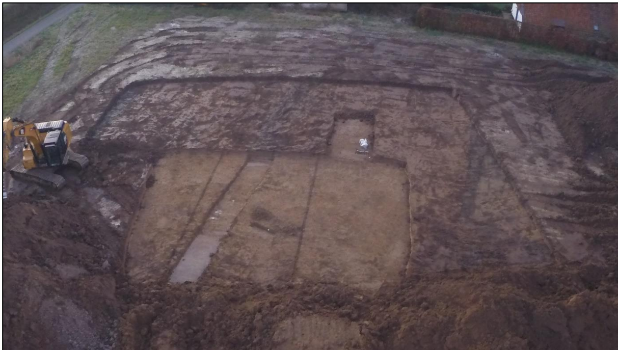
Figuur 54: Dronefoto van de voorbereidingswerken voor de tweede fase van de zuidelijke uitbreiding. De bovenkant van de foto ligt in het zuidzuidoosten.
