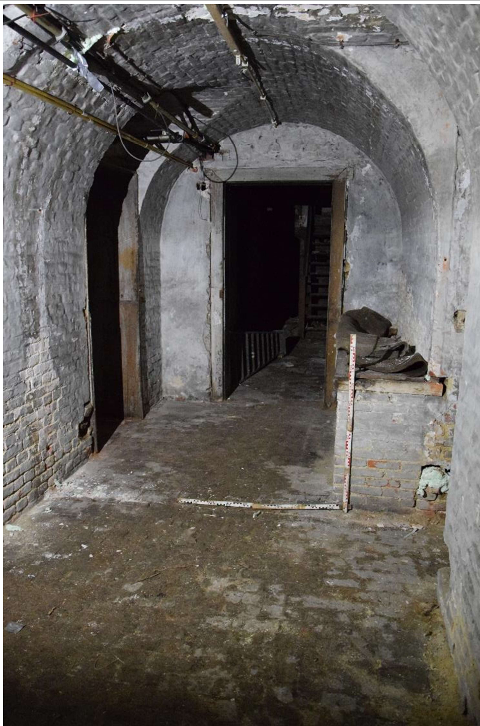
Fig. 4.5: Gang in het noorden van de kelder van Brusselsestraat 77.
