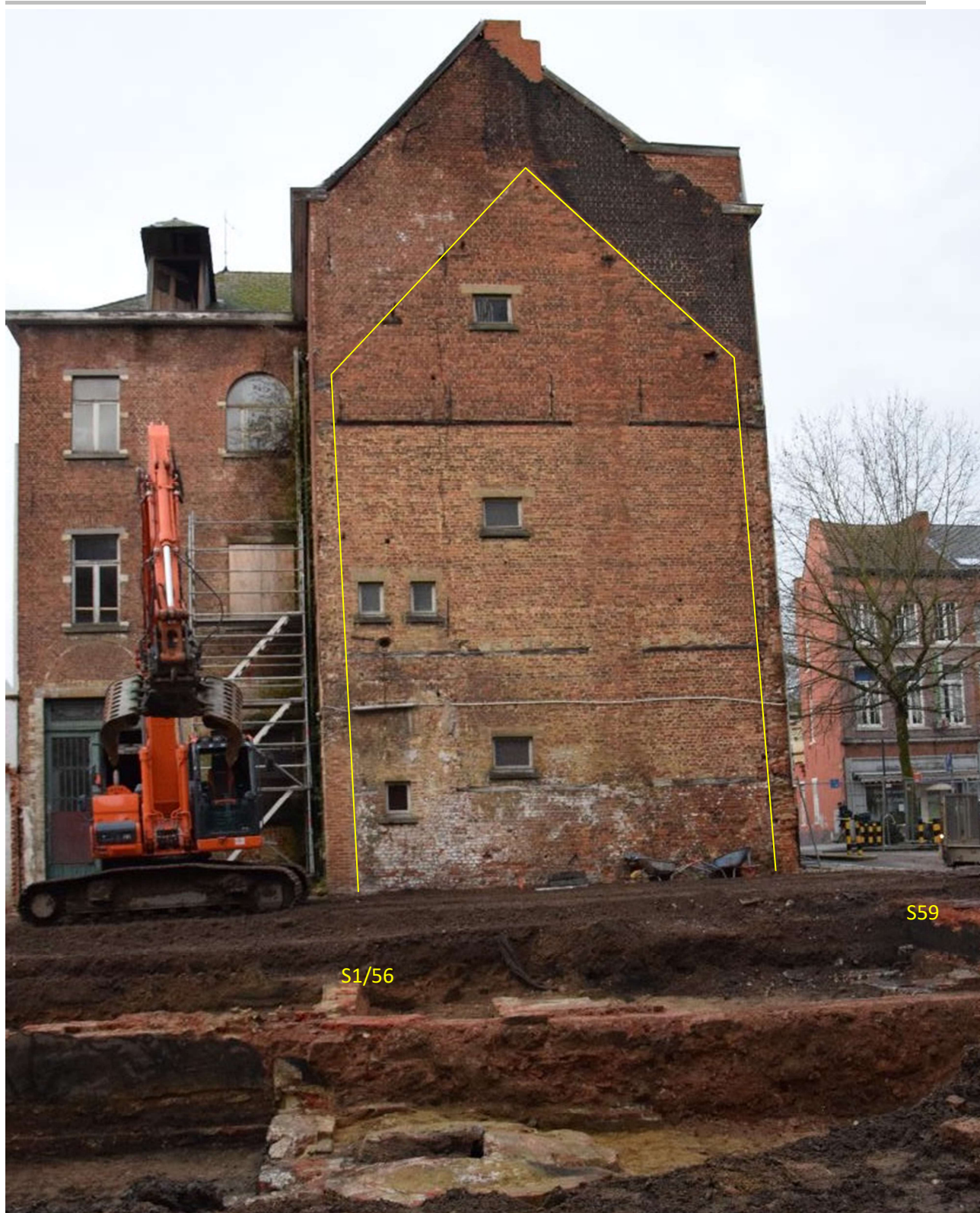
Fig. 3.20: De muren S1 en S59 in werkput 1.
