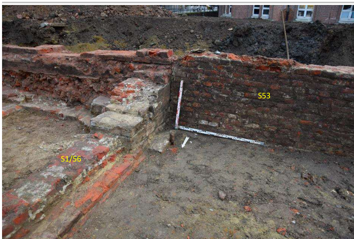
Fig. 3.28: Muur S53 is tegen muur S1/56 aangebouwd.
