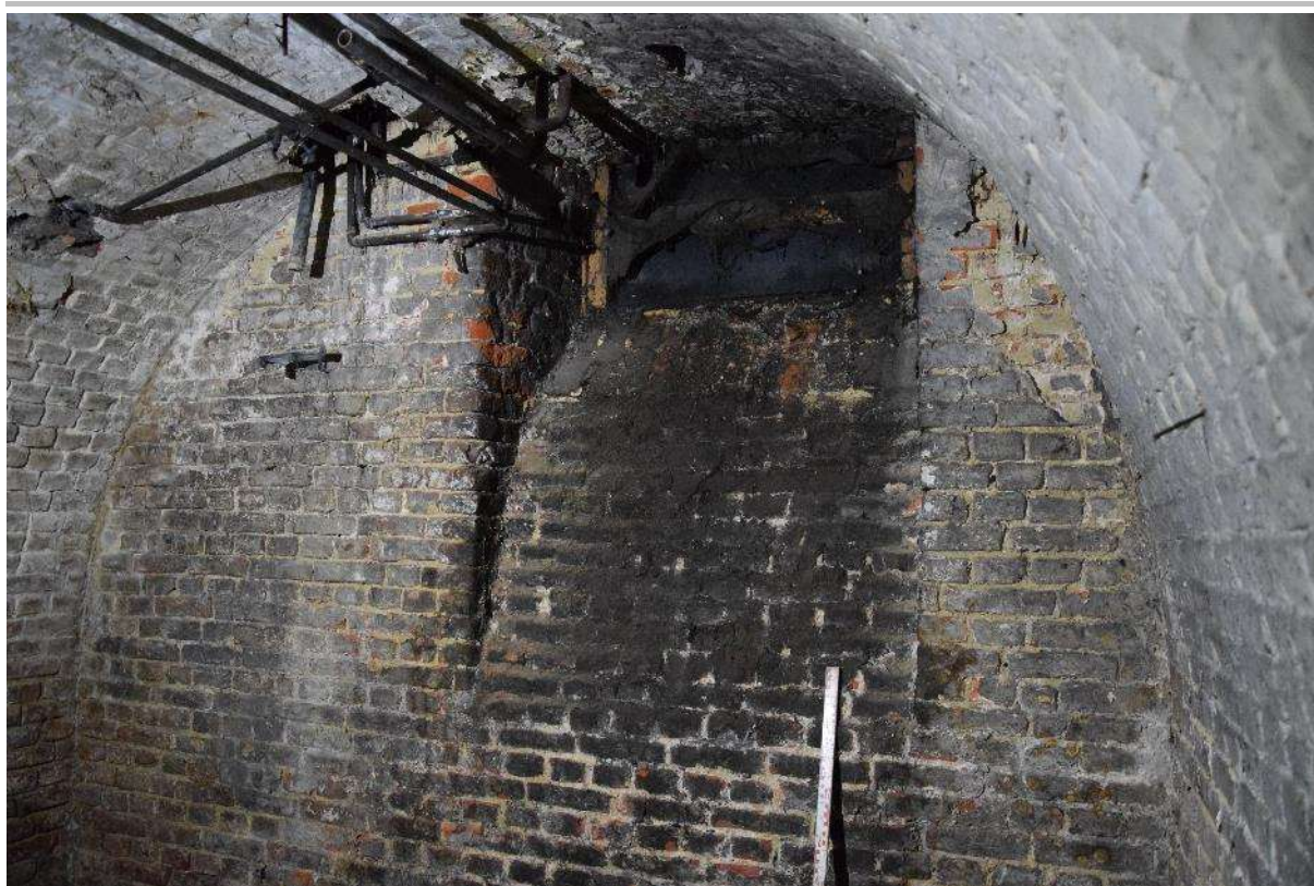
Fig. 4.6: Opening in ruimte met tongewelf in noordelijke zijde van de kelder van Brusselsestraat 77.
