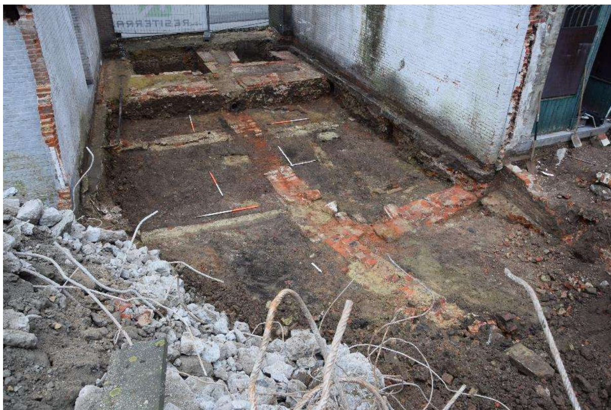
Fig. 3.42: Vlak 2 in werkput 2.
