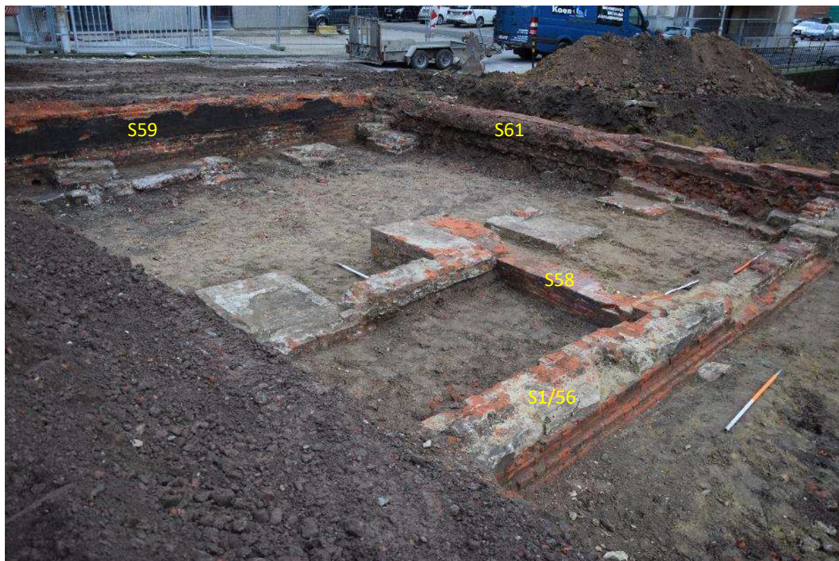
Fig. 3.17: De muren S1 en S59 in werkput 1.
