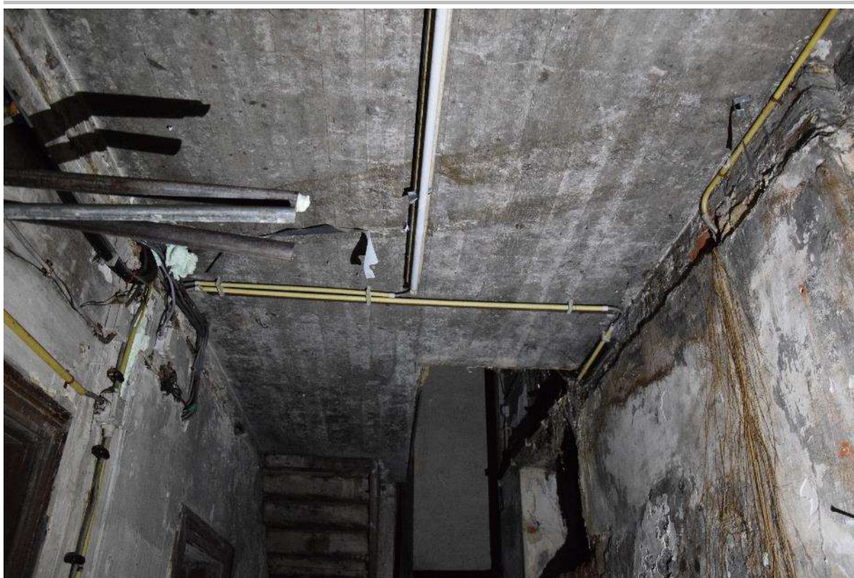
Fig. 4.8: Betonnen welfsel in de zuidelijke zijde van de kelder van Brusselsestraat 77.
