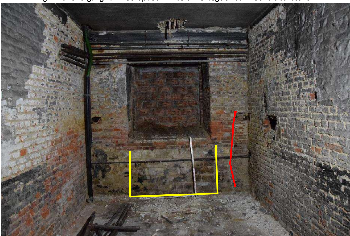
Fig. 4.11: Dichtgemaakte opening (geel) en bouwnaad in kelder onder Brusselsestraat 77.
