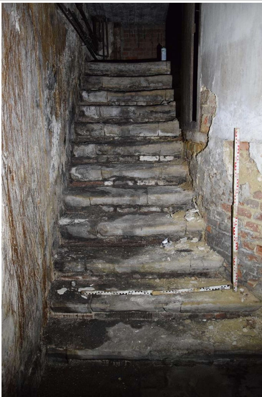
Fig. 4.12: Dichtgemaakte trap in kelder van Brusselsestraat 77.
