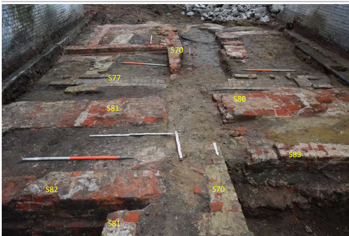
Fig. 3.39: Zicht op de doorbreking van muur S70 door de riolering.
