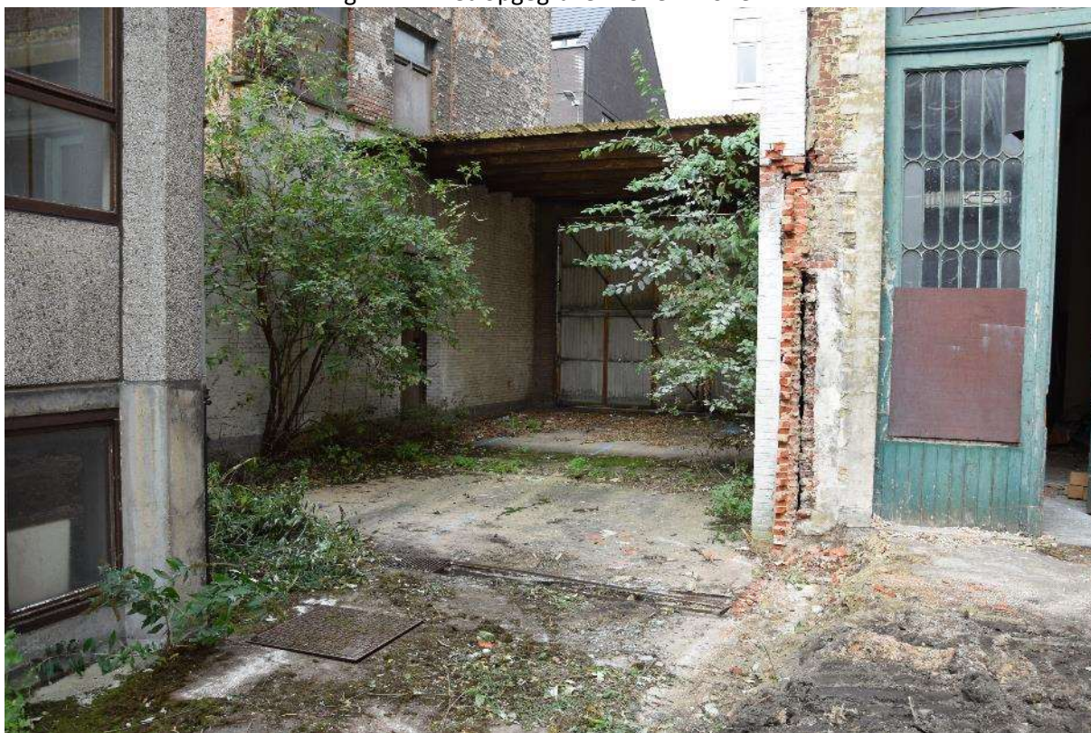
Fig. 1.18: Afdak en poort tussen de huisnummers 77 en 79 in de Brusselsestraat
