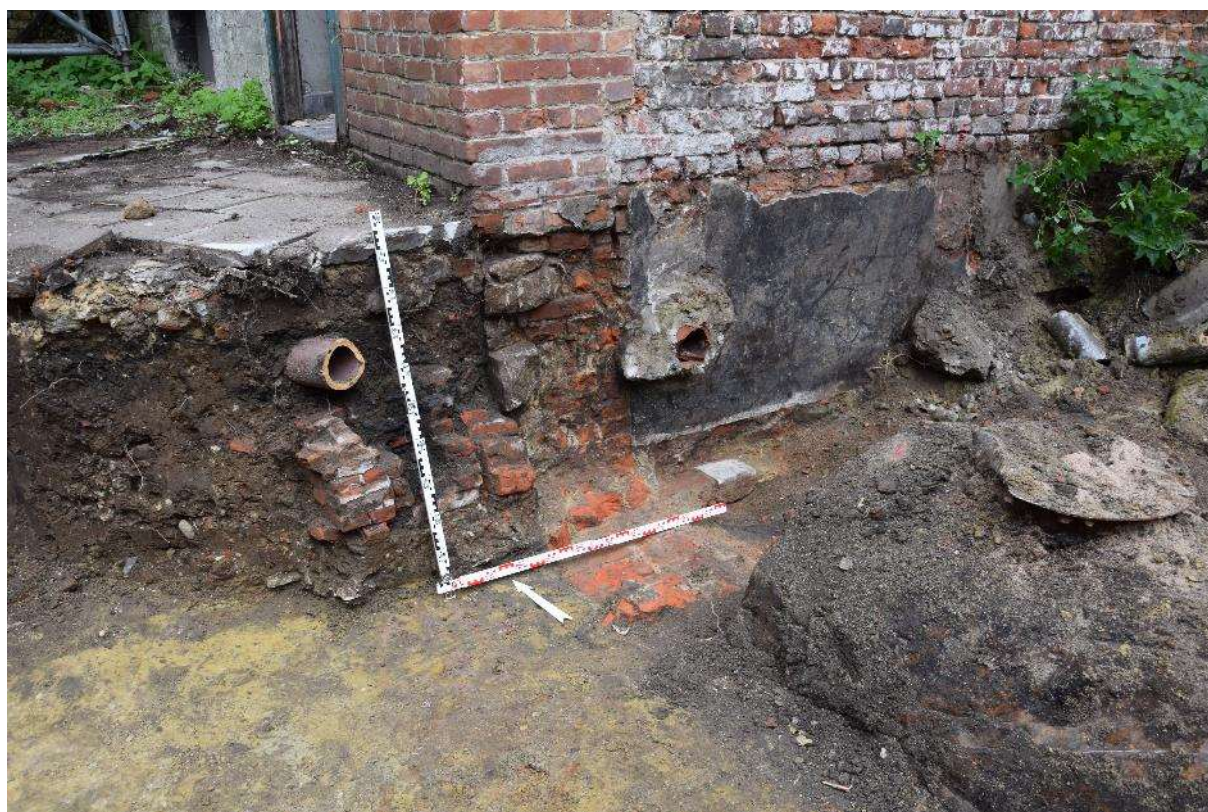
Fig. 3.30: Beploistering tegen de zuidzijde van het hoekhuis Brusselsestraat S77.
