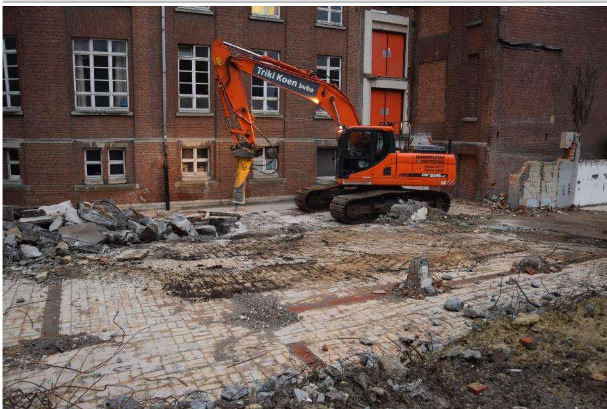
Fig. 1.13: Wegpikeren vloerplaat in het zuidelijk deel van zone 4.
