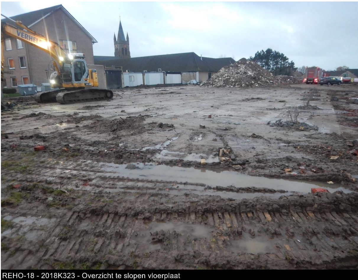
Figuur 8: Overzicht te slopen vloerplaat vanuit de noordoostelijke hoek van de advieszone van de werfbegeleiding.
