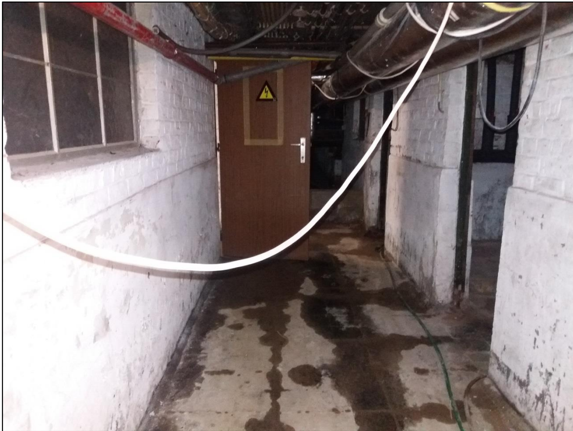
Figuur 10: Foto van de kelder ter hoogte van het te slopen gebouw tijdens een terreinbezoek
