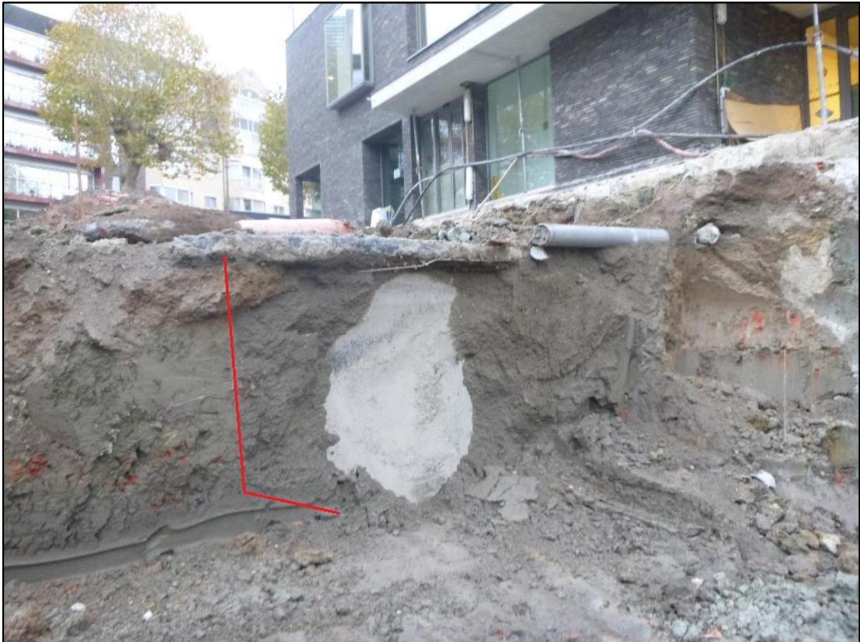
Figuur 62: Algemeen zicht op de onder de vloerplaat aanwezige betonnen citernes. De insteek is in het rood aangeduid (ABO nv 2018)
