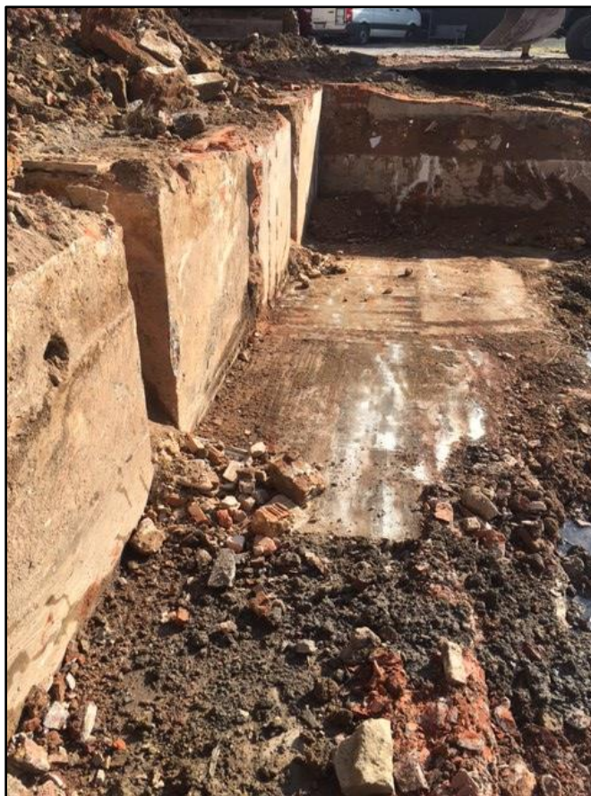
Figuur 22: Algemeen zicht op de kelderverdieping onder het afgebroken beddenhuis voorafgaande de opvulling (Bron: initiatiefnemer 2018)
