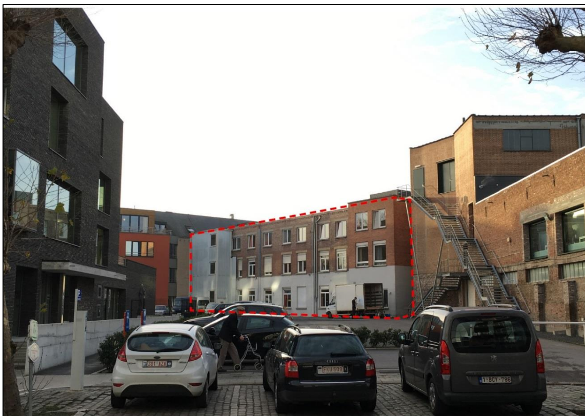
Figuur 6: Huidige situatie vanaf Dam (opdrachtgever 2017)
