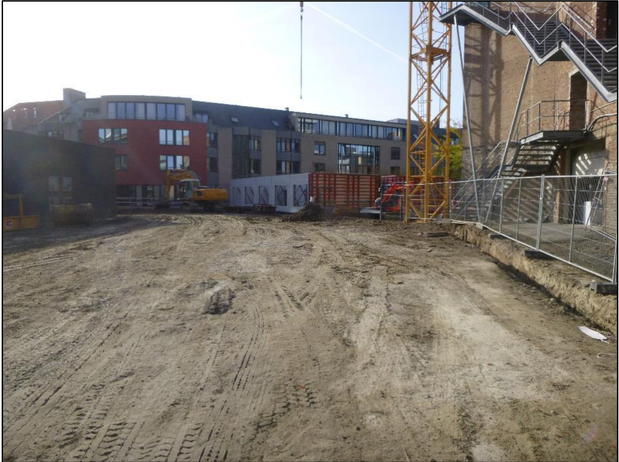
Figuur 25: Algemeen zicht op de zone (Werkput 3) binnen de soilmixwand gezien vanuit het noorden (ABO nv 2018)
