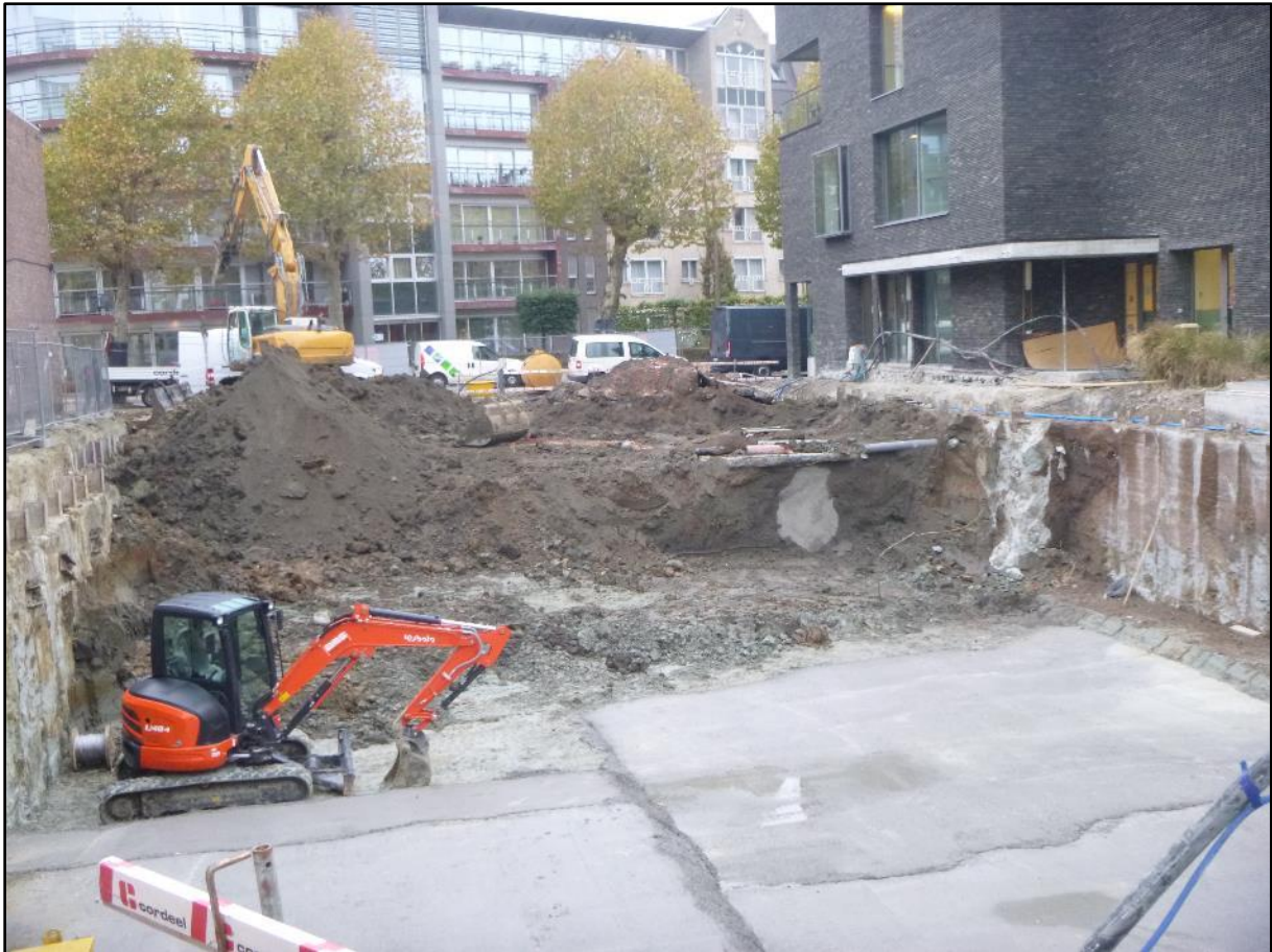
Figuur 61: Algemeen zicht op de werkzaamheden met rechts de aanwezige citernes (ABO nv 2018)
