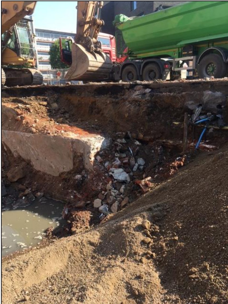
Figuur 23: Opvullen van de bestaande kelders met zeefzand (Bron: initiatiefnemer 2018)
