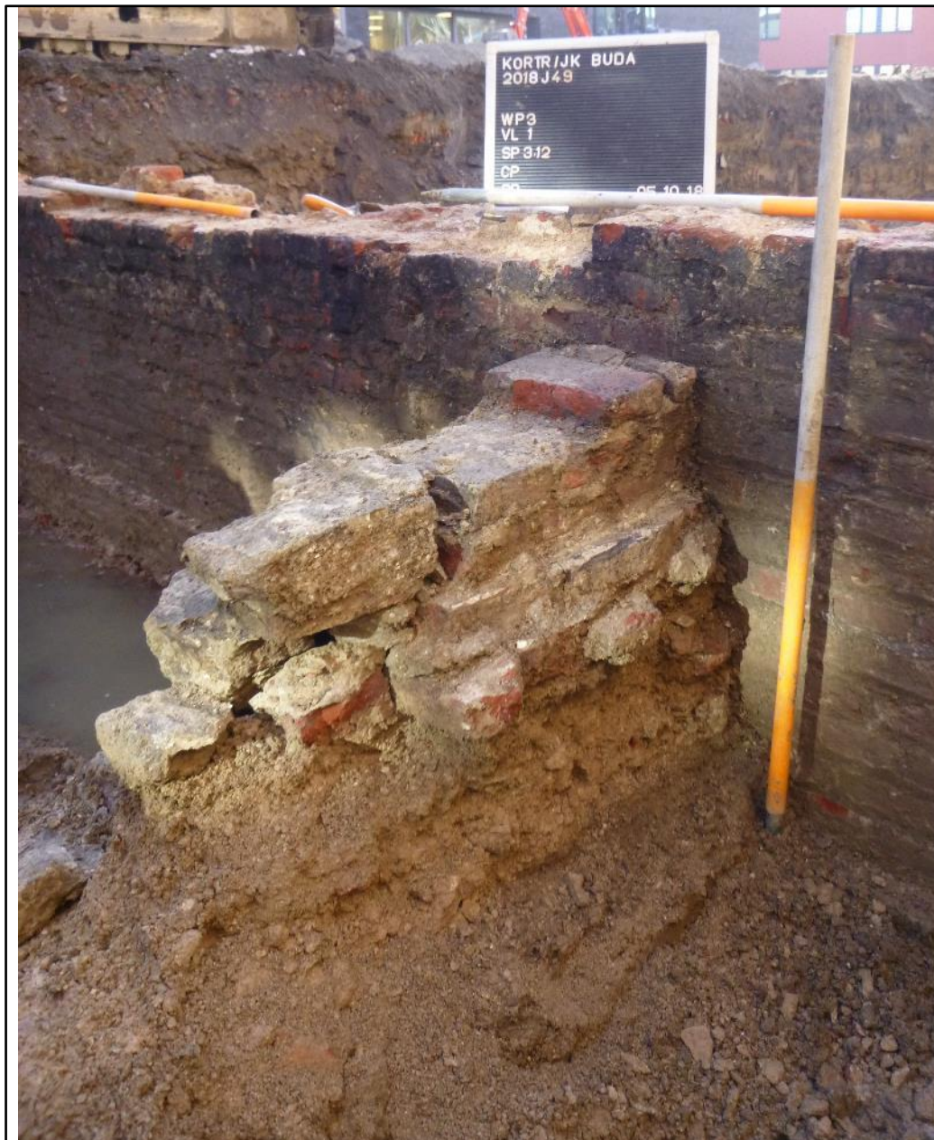
Figuur 55: Vooraanzicht restant bakstenen riool aan de noordelijke zijde (ABO nv 2018)
