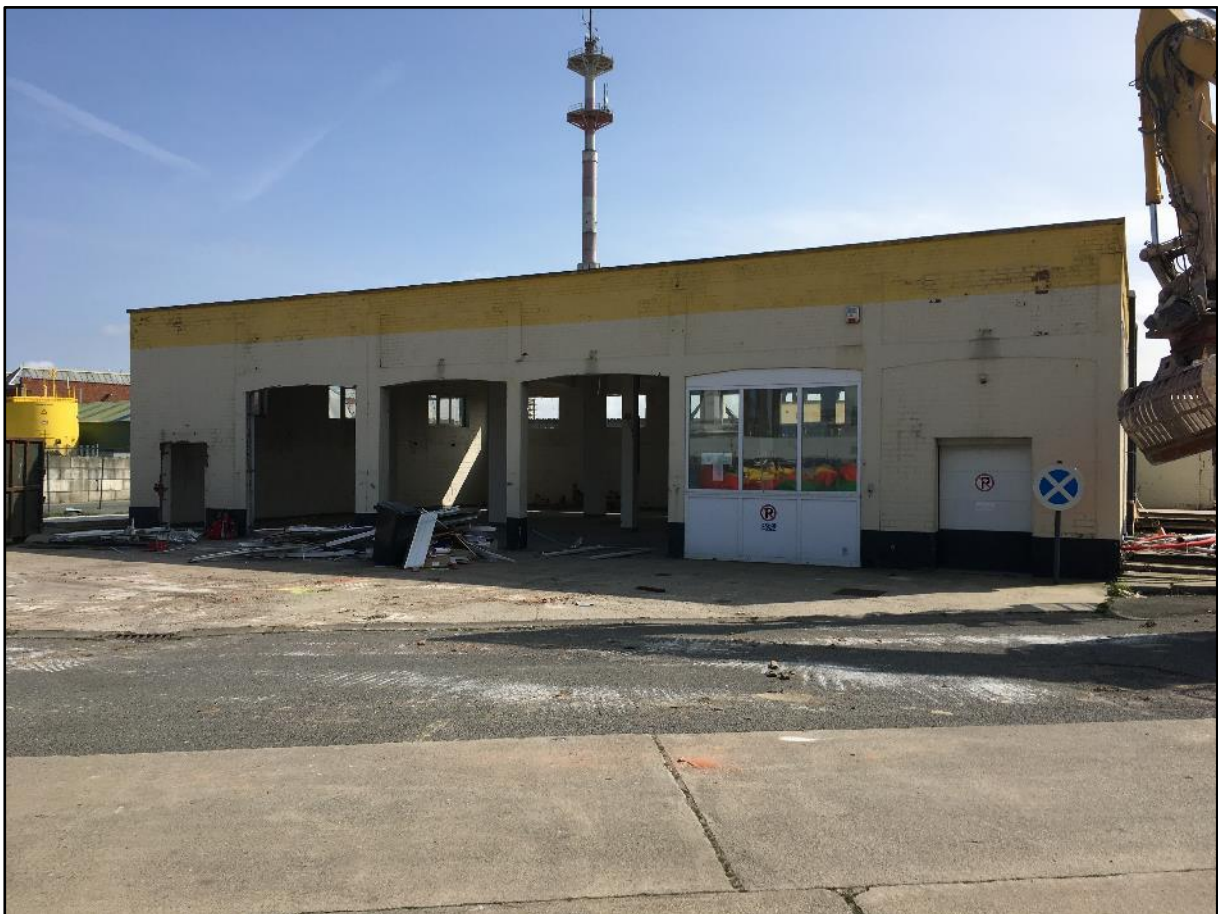
Figuur 16: Aanwezige bebouwing en verhardingen voorafgaand de sloop (ABO nv 2019)
