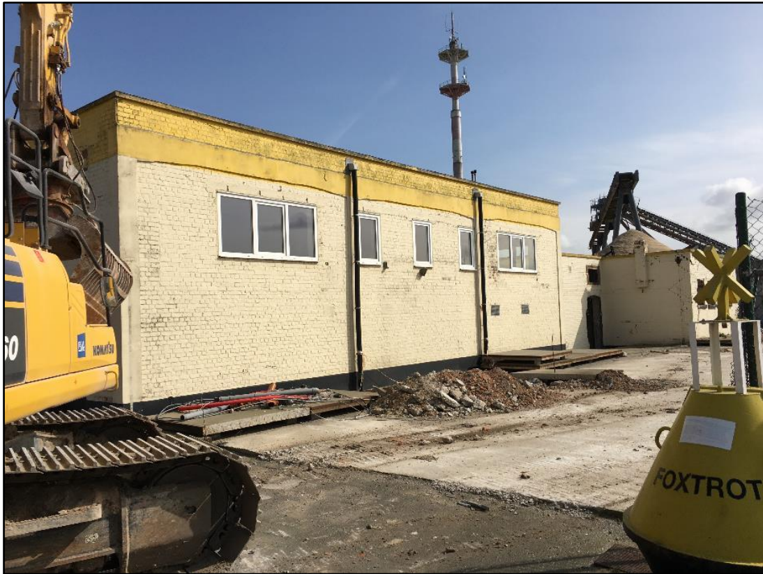
Figuur 17: Aanwezige bebouwing en verhardingen voorafgaand de sloop (ABO nv 2019)
