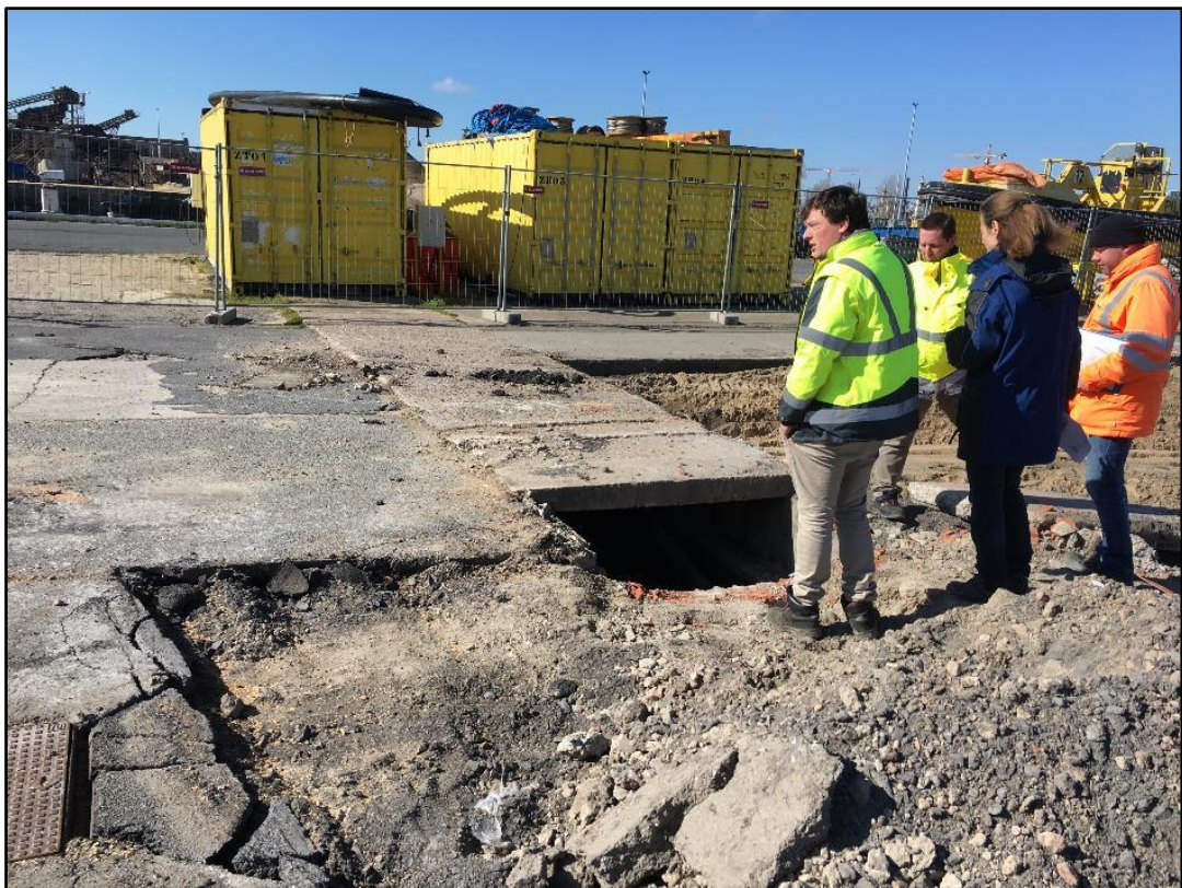
Figuur 20: Algemeen zicht op het onderzoeksgebied na sloping met aanwezige kruipkelder met nutsleidingen (ABO nv 2019)
