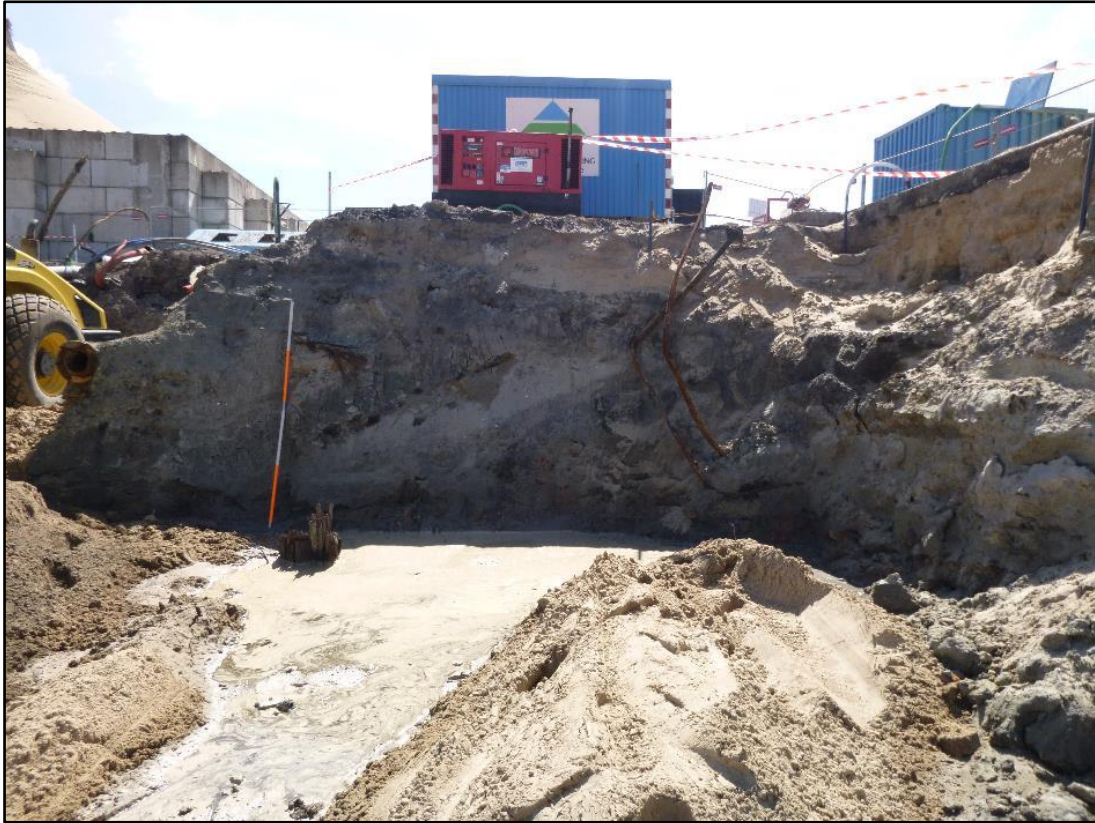
Figuur 24: Recente ophoging door middel van puin en schroot (ABO nv 2019)
