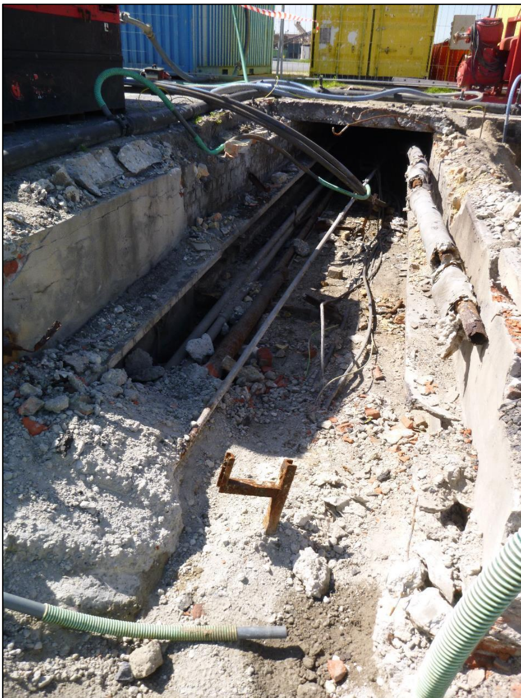
Figuur 21: Aanwezigheid van ondergrondse kruipkelder met nutsleidingen (ABO nv 2019)
