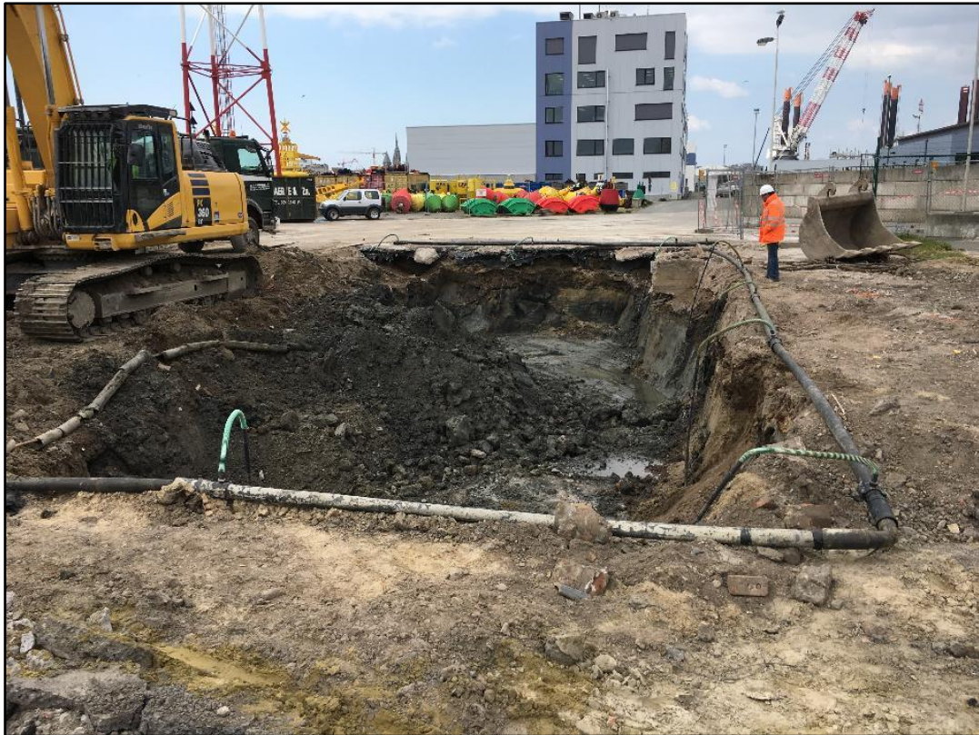
Figuur 22: Aanvang van de sanering (ABO nv 2019)
