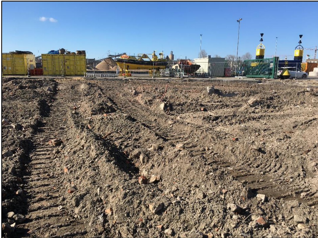
Figuur 19: Algemeen zicht op het onderzoeksgebied na sloping (ABO nv 2019)
