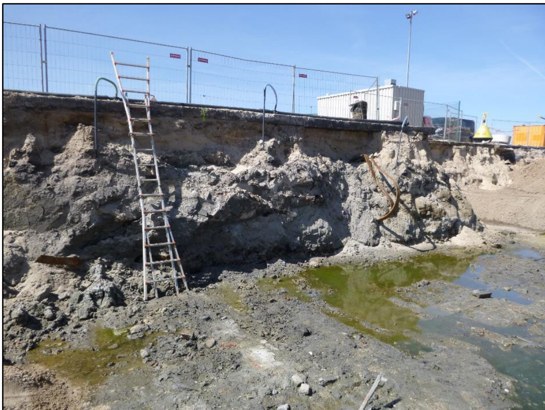
Figuur 23: Recente ophoging door middel van puin en schroot (ABO nv 2019)
