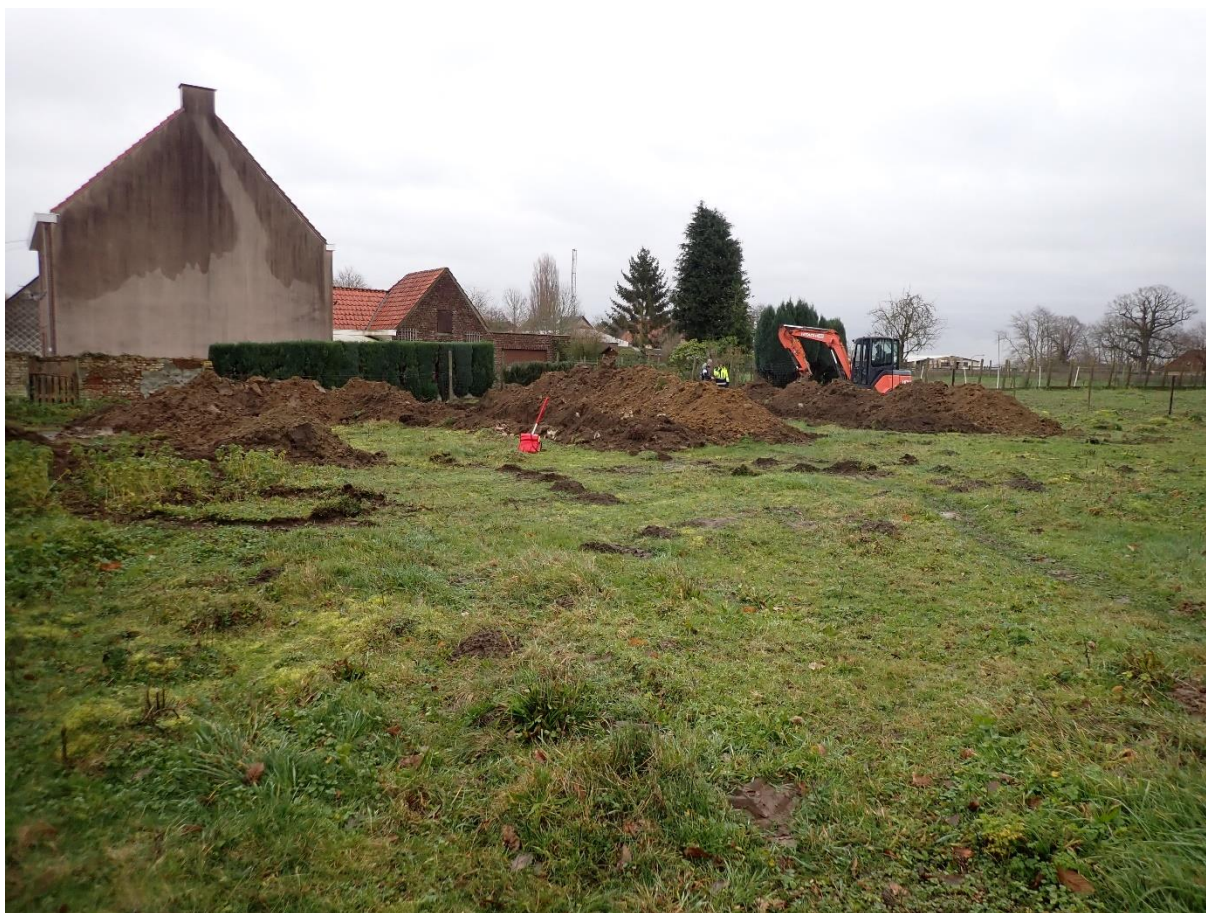
Figuur 25: zicht op de uitvoering van de sleuven (© J. Verrijckt Bvba)
