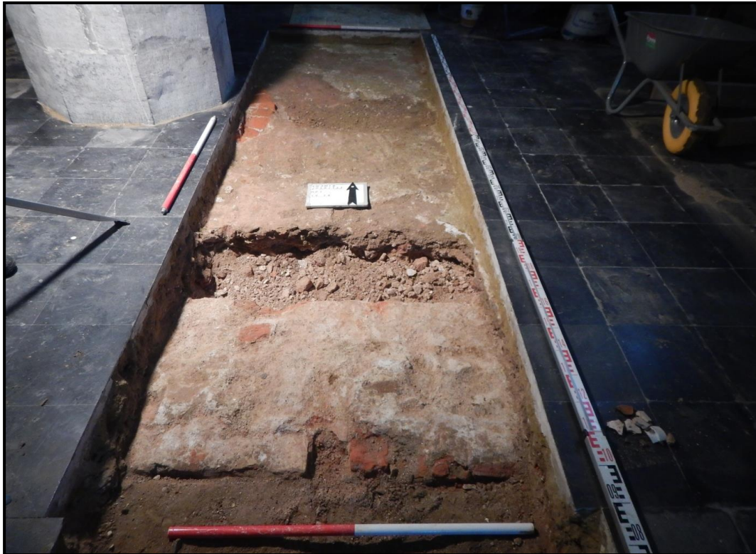
Figuur 24: Het noorden van WP1 met op de voorgrond de zuidelijke bakstenen zijmuur (S9) van de oude W-O georiënteerde kerk. Merk op de achtergrond het kalkmortellaagje (S11) op dat als het werkniveau van de nieuwe kerk gezien kan worden.
