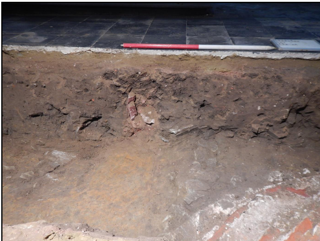
Figuur 18: Zicht op het oostprofiel in het zuiden van WP1 met ook zicht op een mogelijke paalkuil (eveneens opgevuld met los puin) die het resultaat is van het gebruik van houten stellingen bij de bouw van de eind 18 de eeuwse kerk.
