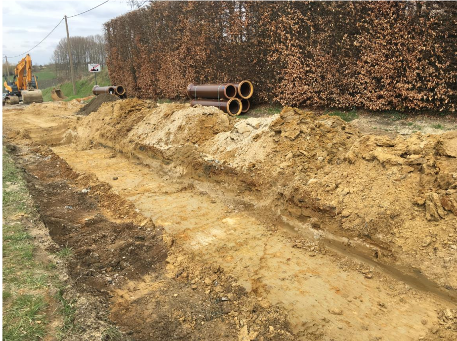
Figuur 6: Werkfoto genomen vanuit het kruispunt Kolmontstraat-Jesserenweg (bron: ABO nv 2019)
