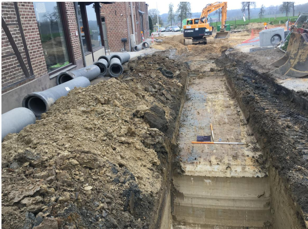
Figuur 14: Zicht op de werksleuf in de Kolmontstraat (bron: ABO nv 2019)
