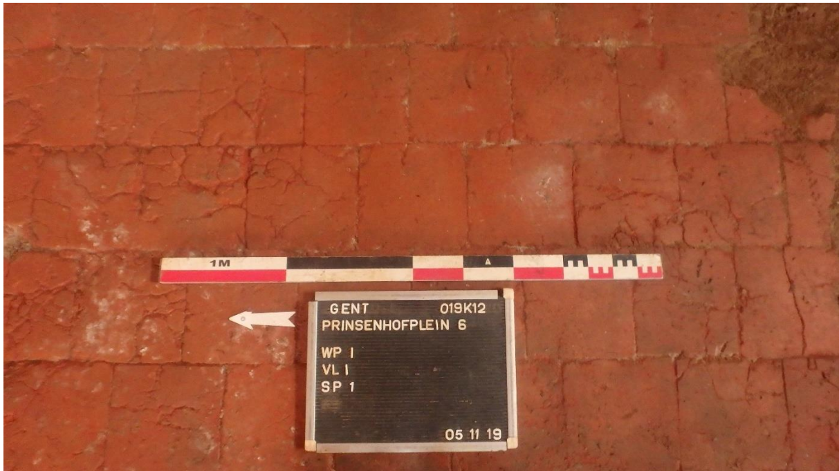
Figuur 2: Detail van vloer S1001 in Kamer A.
