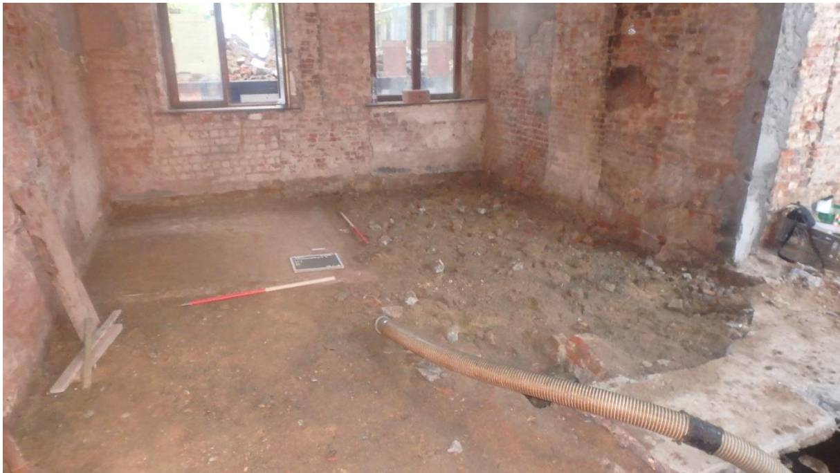
Figuur 8: Overzicht in Kamer C met in de linkerbovenhoek vloer S3001 en fundering S3002. Foto richting westen.
