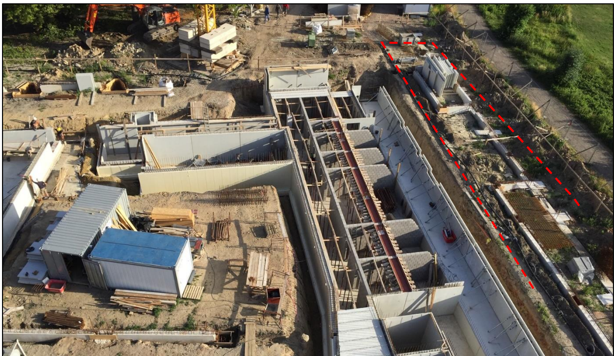
Afb. 6: Zicht op de afgegraven westzijde van het tracé (rood) (Bron: Vandersmissen nv, dd. 16/6/2017, 2018J196).
