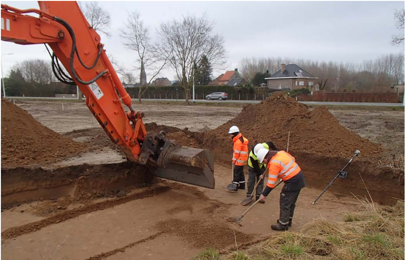
Figuur 22: Het verwijderen van de ploeglaag met een rupskraan
