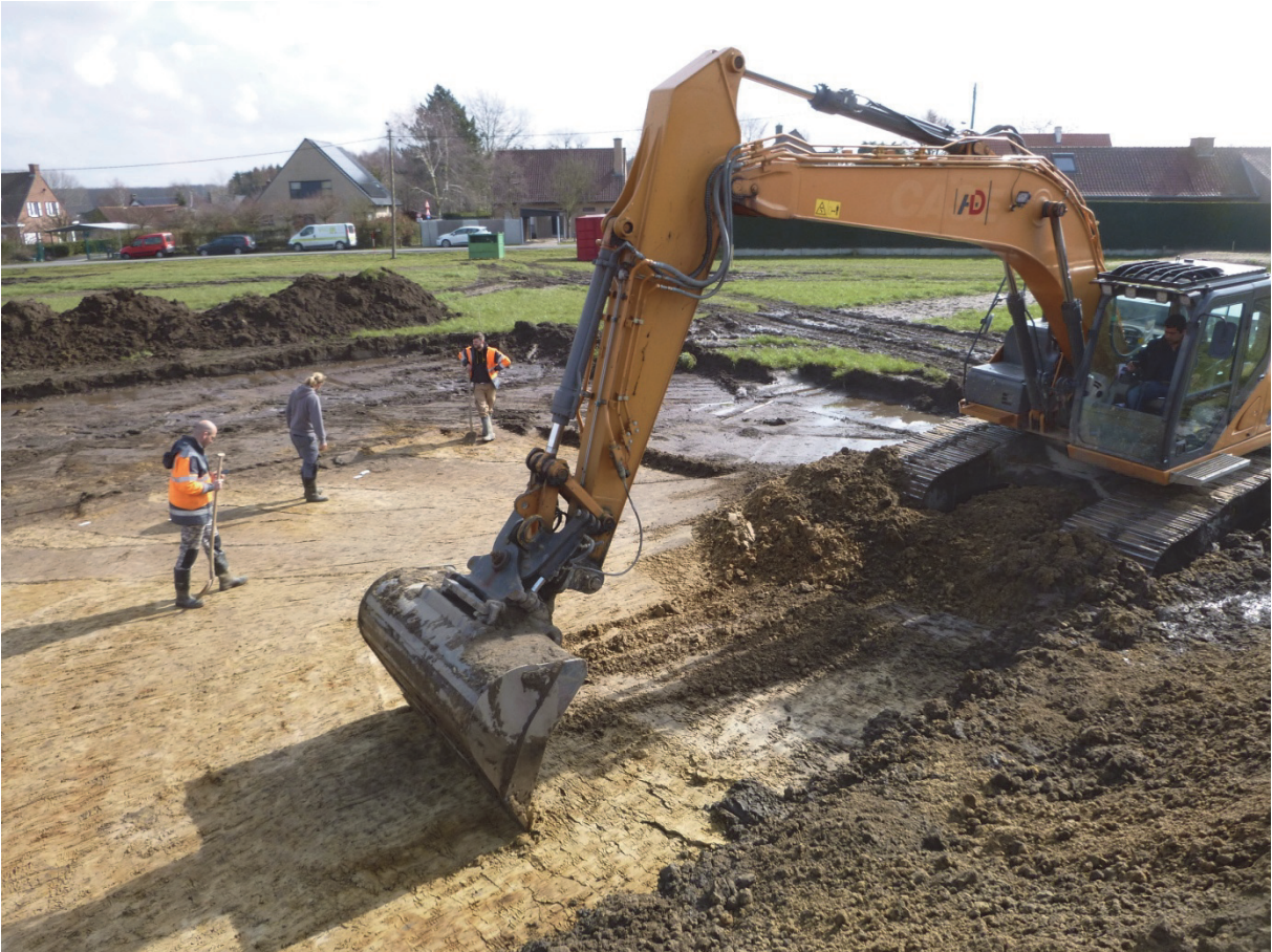
Afb. 1.4. Sfeerimpressie van de aanleg van een sporenvlak.
