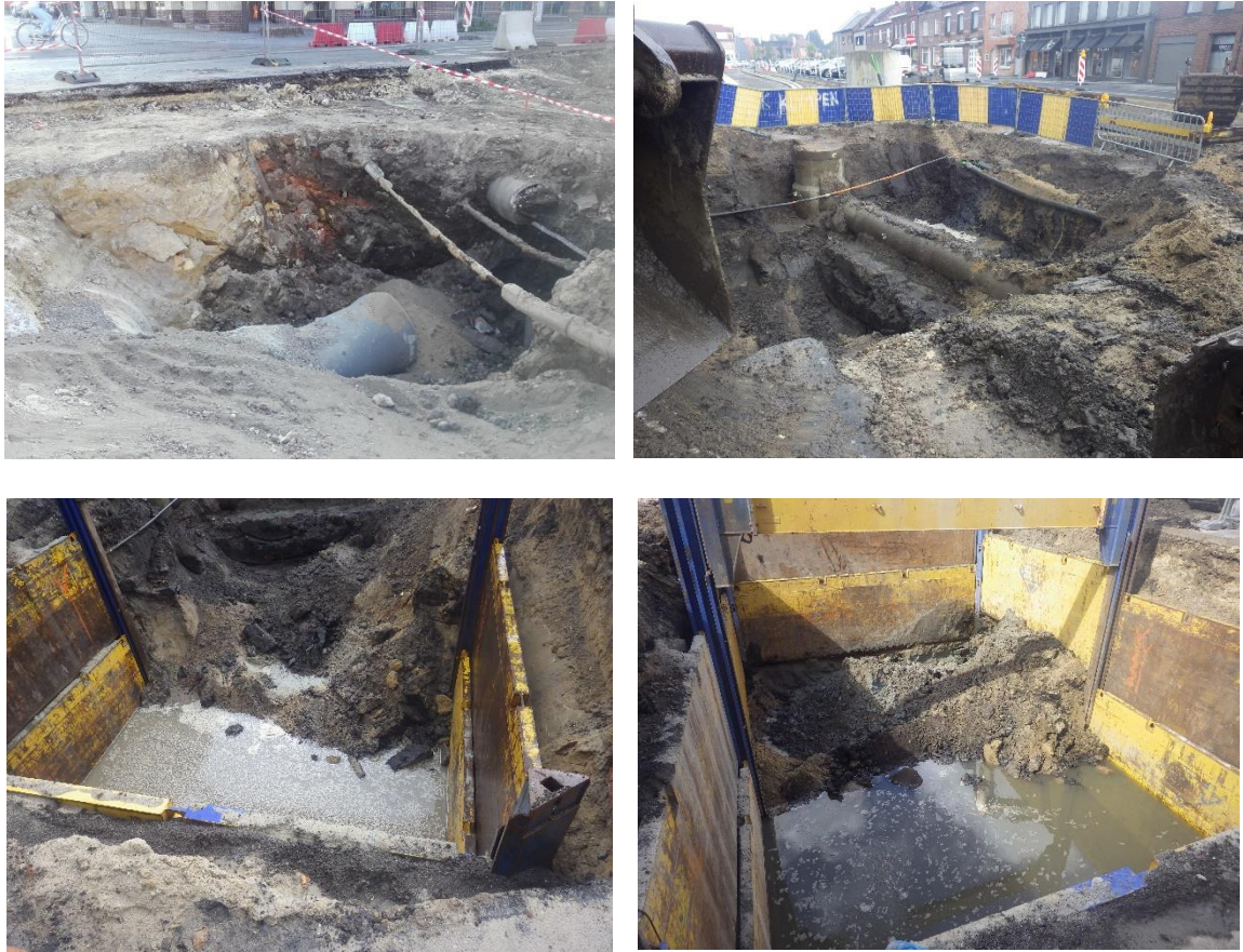
Fig. 23: nutsleidingen op het kruispunt Stationswal/Hoogstraat/Malta en het onmiddellijk plaatsen van damwanden voor de bouw van de collector met (onder) een beeld van het (grond)water afkomstig van de lekkende Breeërstadsbeek en instortende bodemprofielen.
