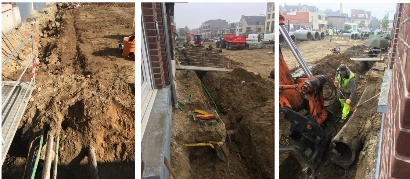
Fig. 30: Het opbreken van de bestaande nutsleidingen aan de binnenzijde van de Stationswal. De bebouwing aan de binnenzijde van de wal kwam bovendien pas op gang nadat de wallen geslecht waren en er een open, toegankelijke ruimte ontstond. Het gemeentebestuur wordt vanaf dan overstelpt met aanvragen om openingen te mogen maken in afsluitingen naar de wallen en om deuren en vensters te mogen maken in de gevels met uitzicht op de nieuwe brede laan rond het stadscentrum 17 .
