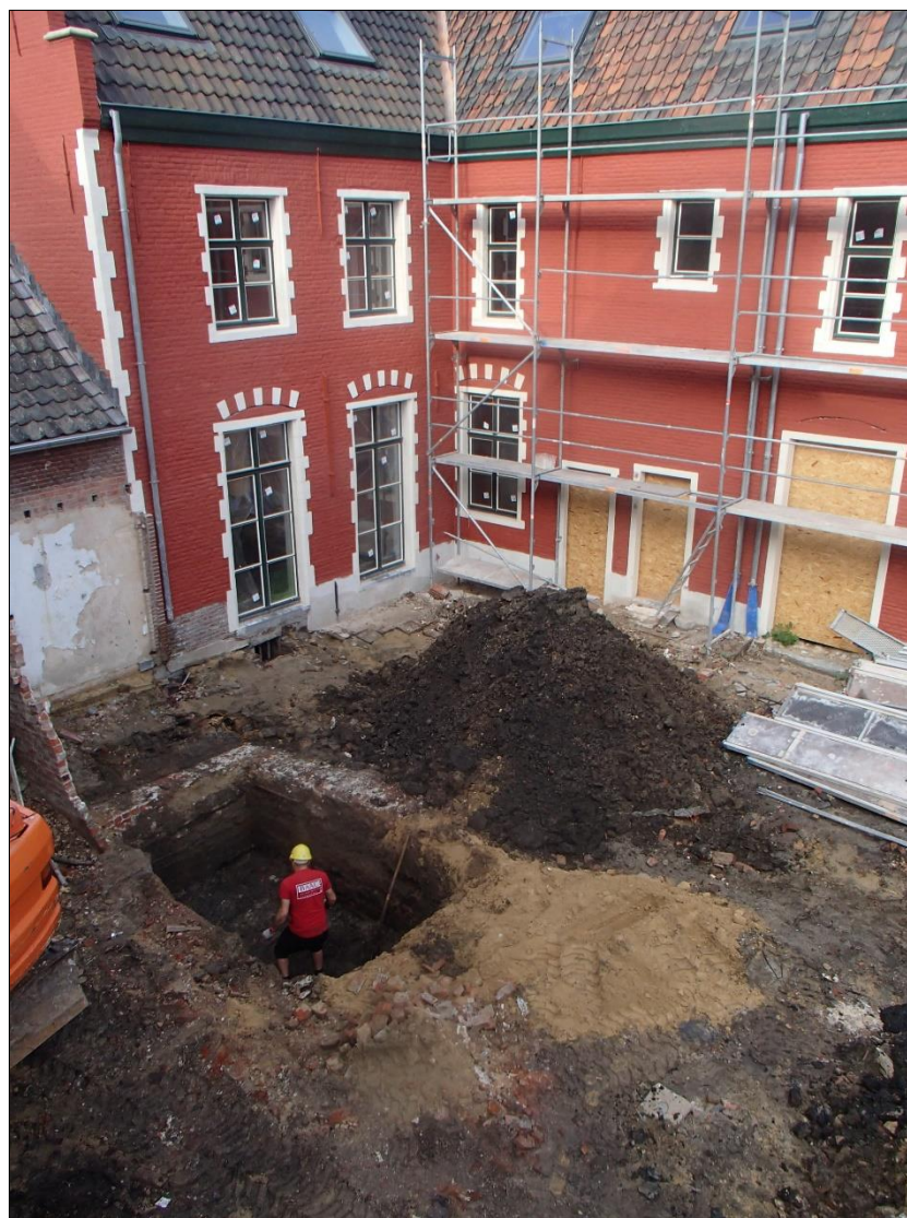
Figuur 3: Overzicht van de centrale binnentuin met werkput 1.
