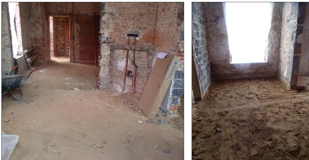
Figuur 2: Uitgegraven vloerniveau binnen de panden
