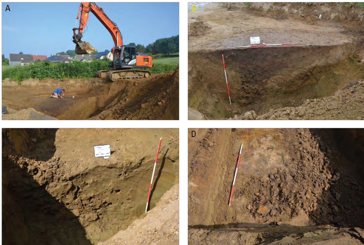
Fig. 6.10. Lubbeek-Tempelbeek. Impressie van de werkzaamheden aan waterput S1.51.
