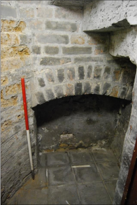
Figuur 30: Originele toegangsdeur traptoren
