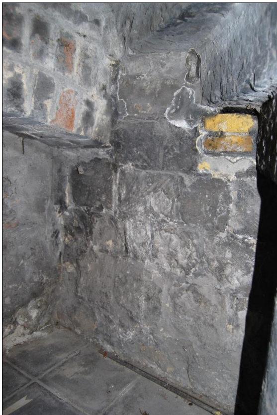
Figuur 31: Zuidelijke zijwand van de toegang bekleed met Artesische kalksteen
