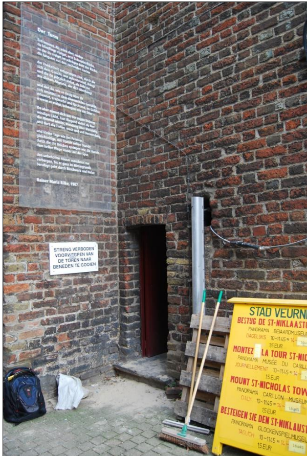
Figuur 34: Huidige toegang buitenzijde
