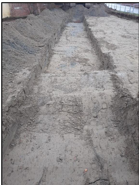
Figuur 39: Zicht vanuit het noordoosten op de centrale sleuf in zone 1. Ook deze bestond volledig uit recent ophogingszand (© Monument Vandekerckhove).
