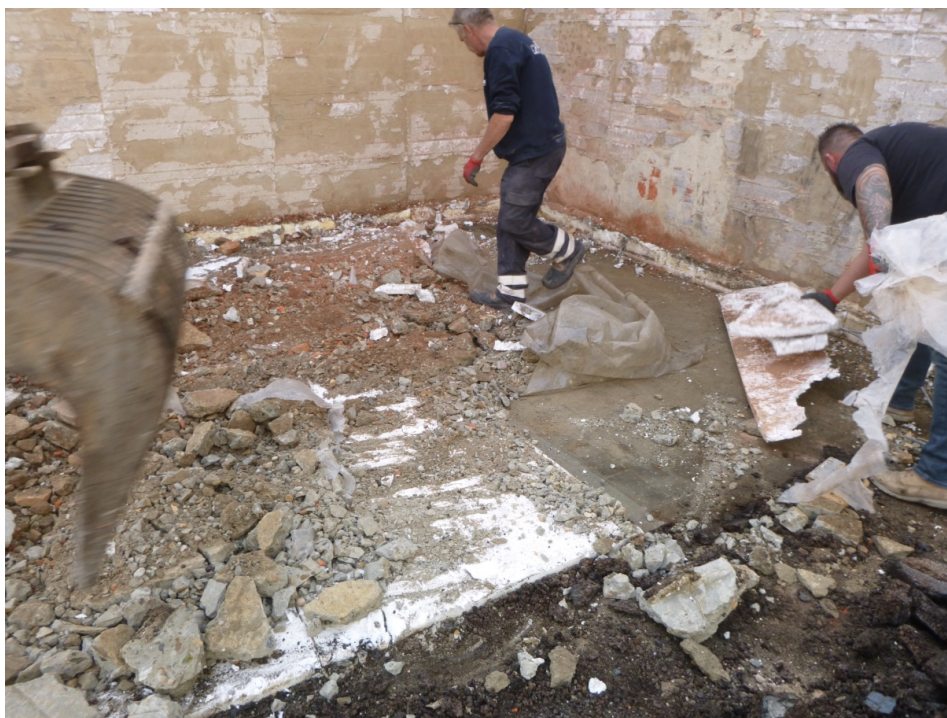
Afb. 3.3. Het oude vloerniveau werd afgedekt met plasticfolie, piepschuim, en recent bouwpuin.
