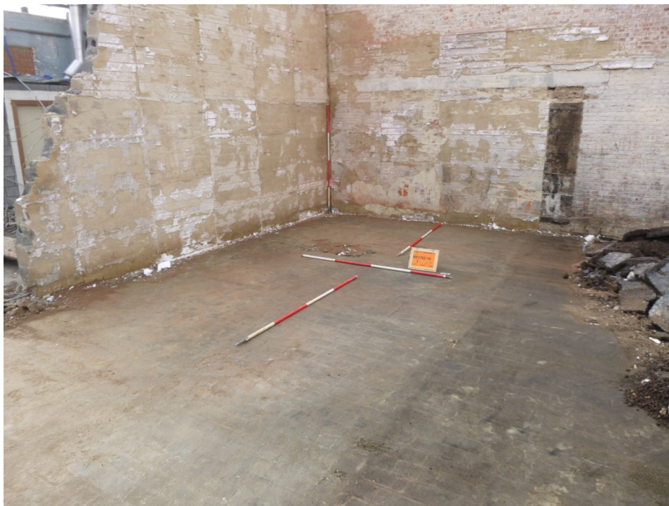
Afb. 3.1. Onder het afgebroken vloerniveau kwam een tweede vloerniveau tevoorschijn.
