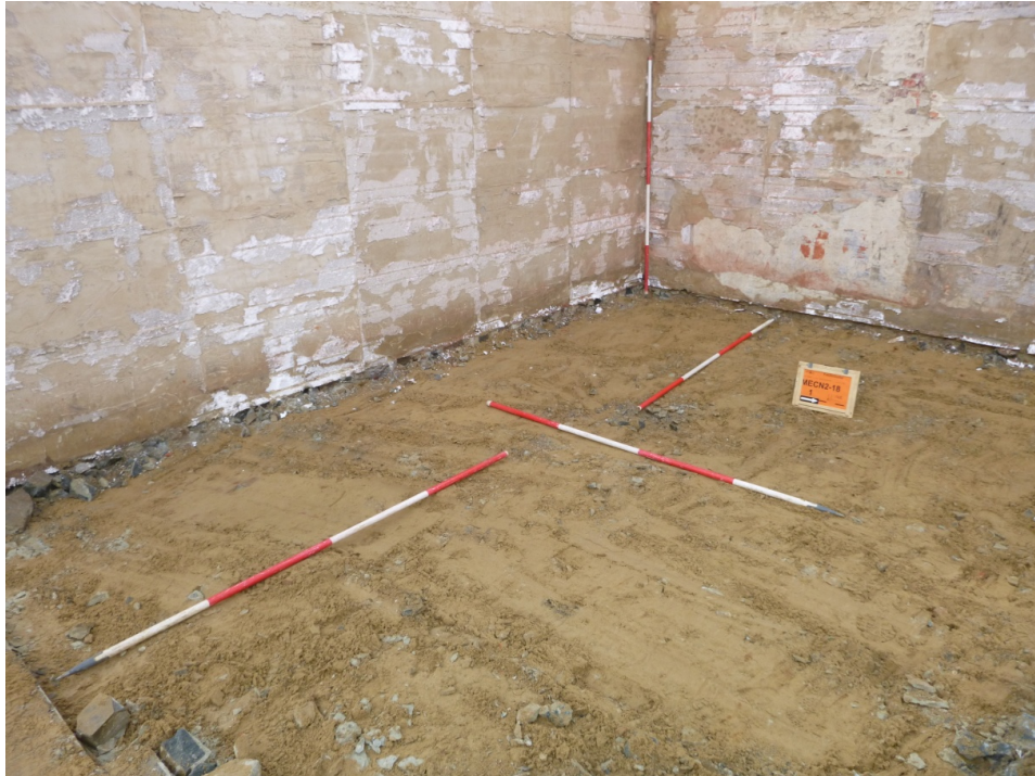
Afb. 3.4. Zicht op de stabilisatielaag onder de vloer.
