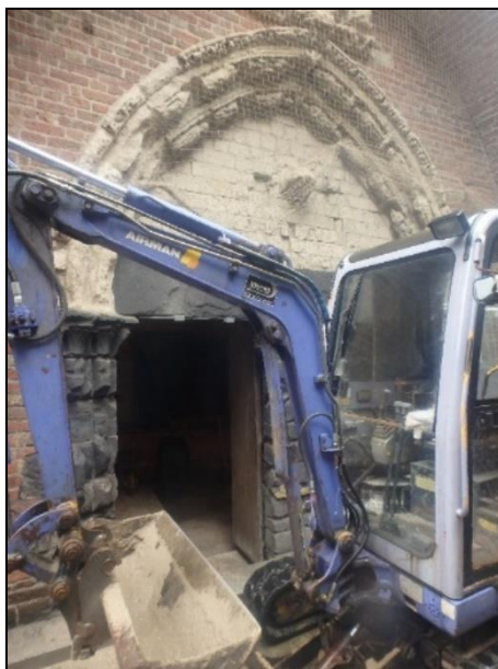
Figuur 6: Zicht van buiten de kerk op het westportaal tijdens de werkzaamheden
