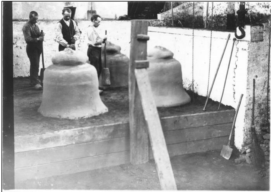
Figuur 63: Ingraven van de gietmallen 74
