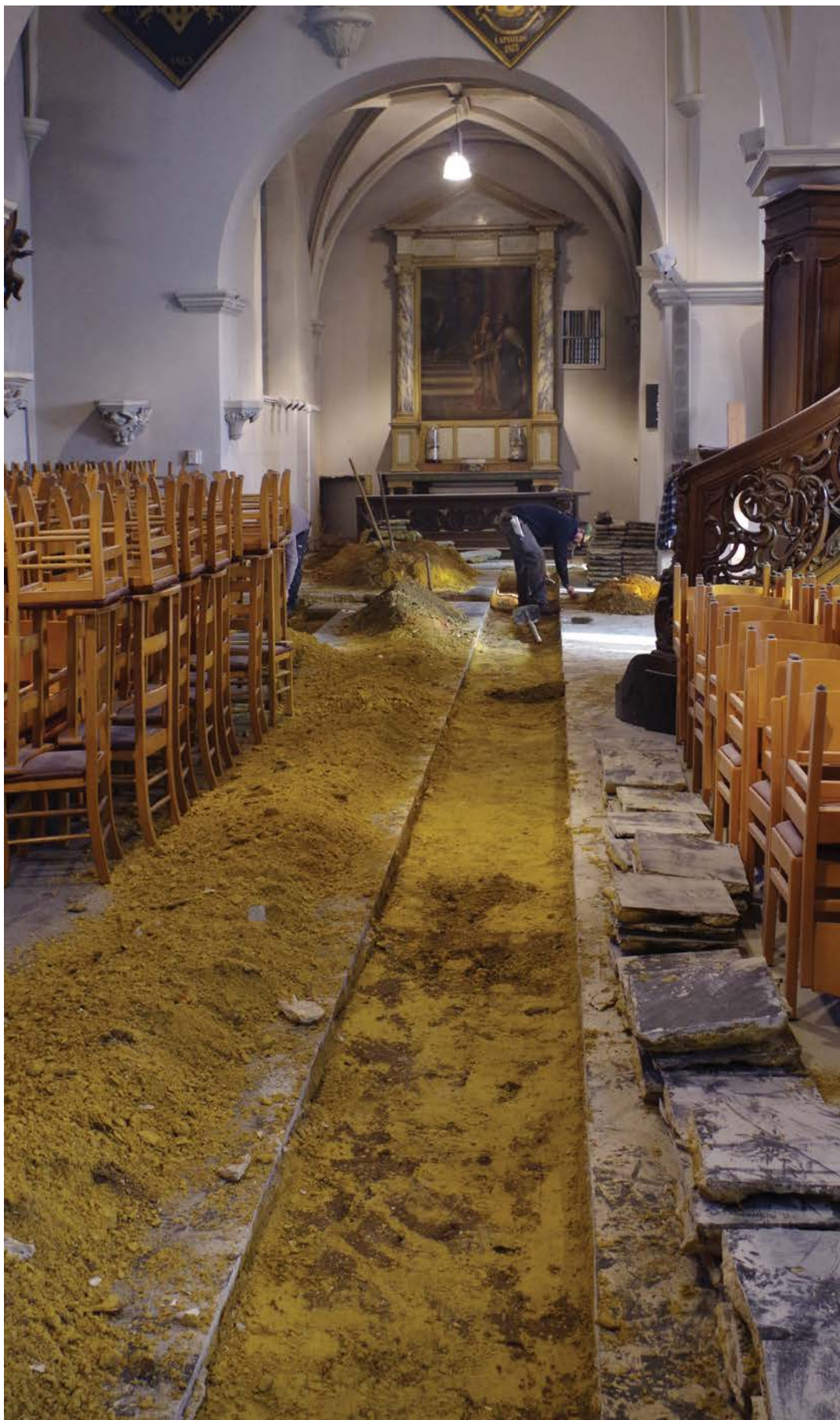
Fig. 6. Zicht op de leidingsleuf ter hoogte van de noordwestelijke zijbeuk, nadat de bestaande tegelvloer werd uitgebroken en het verwijderen van het onderliggende zandbed van de vloer werd gestart.
