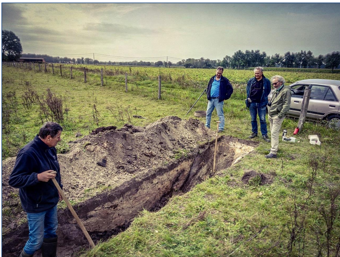
Figuur 2. Handmatige aanleg van de eerste profielsleuf.
