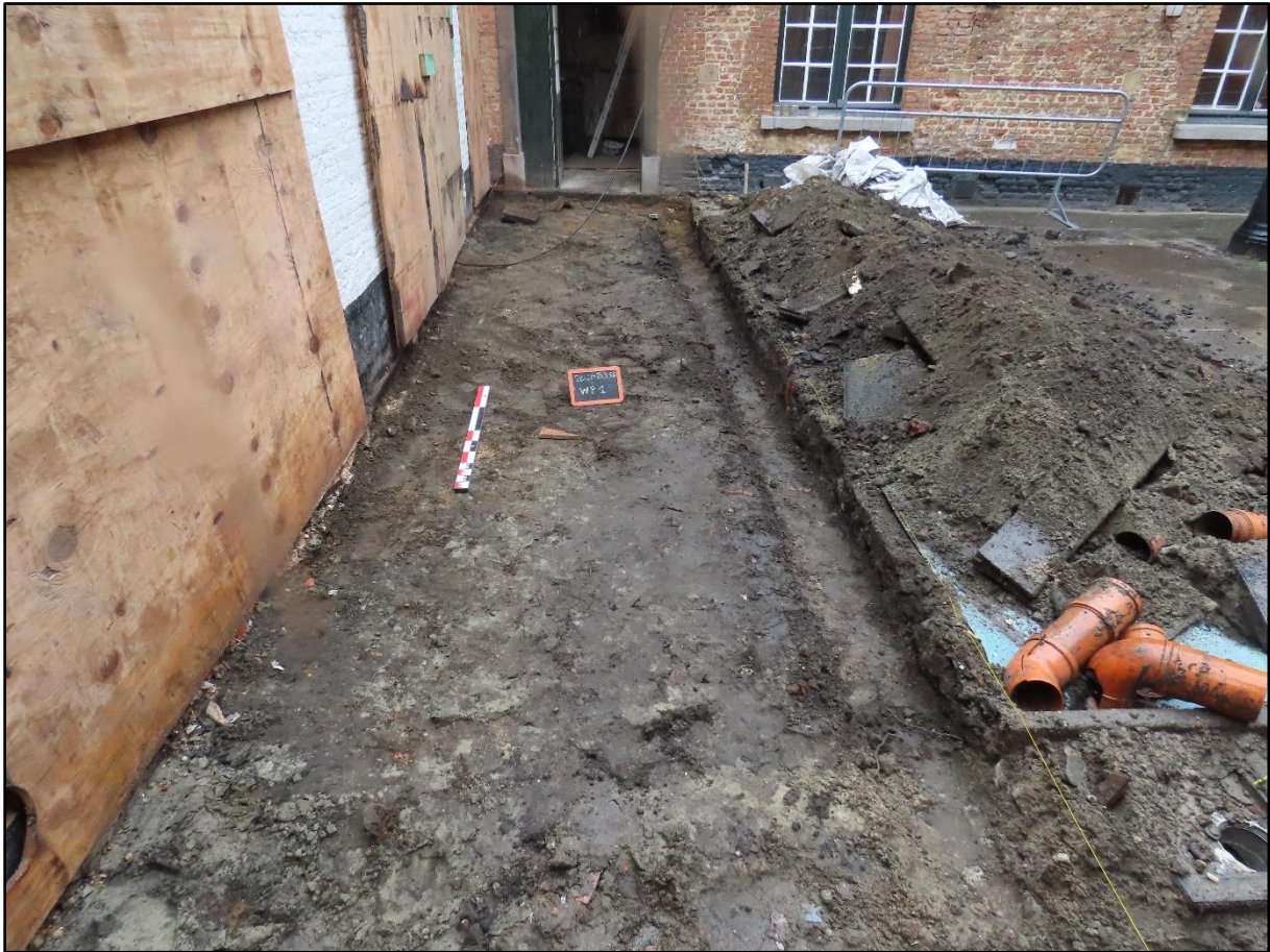
Figuur 36 Zicht op werkput 1 na het uitgraven, gezien vanuit het oosten. Rechts op de foto is de iets diepere uitgraving van de funderingsseuf te zien.
