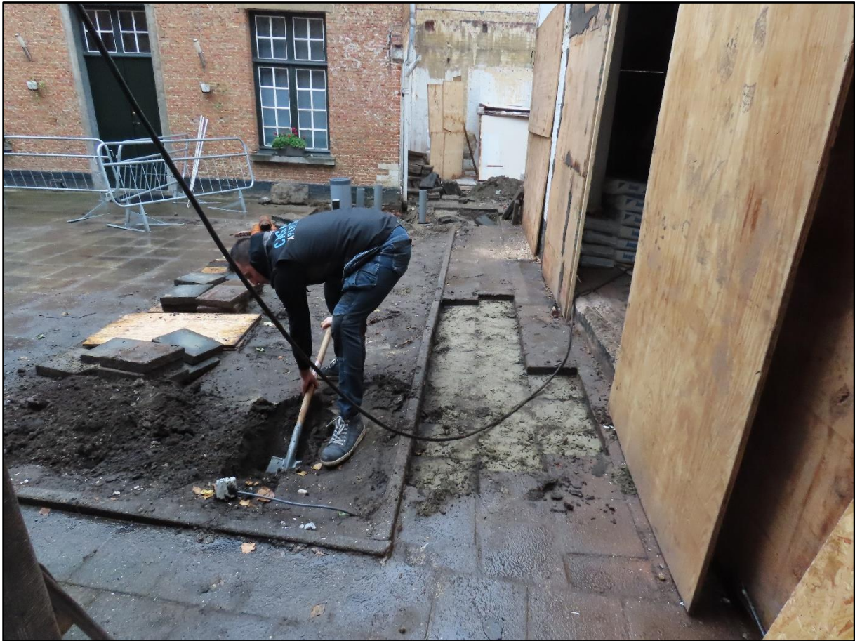
Figuur 11 Manuele uitgraving voor de funderingssleuf in werkput 1.
