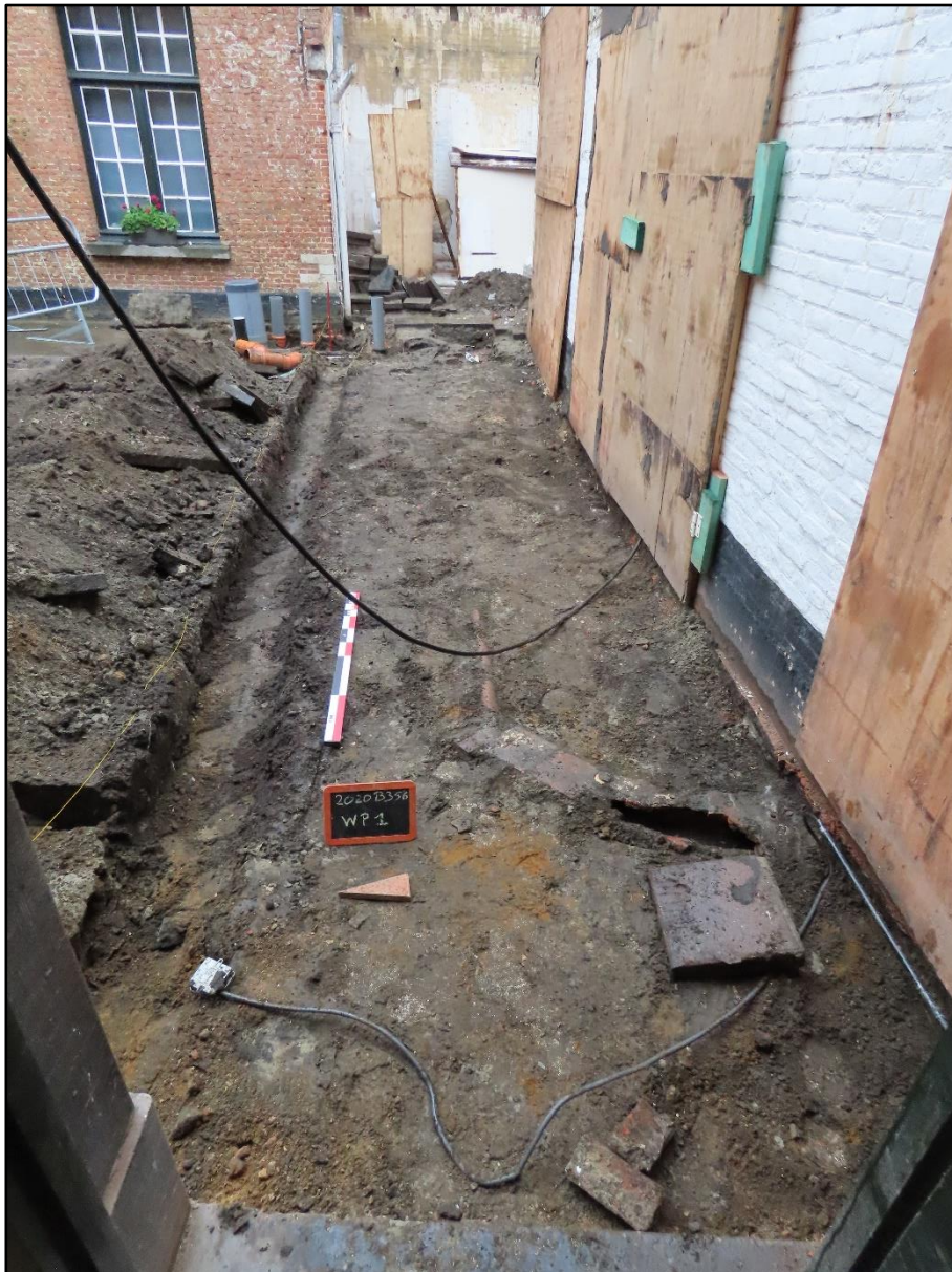
Figuur 34 Zicht op werkput 1 na het uitgraven, gezien vanuit het westen. Op de voorgrond de verstoring veroorzaakt door de nog werkende afvoerleiding. Links op de foto is de iets diepere uitgraving van de funderingssleuf te zien.
