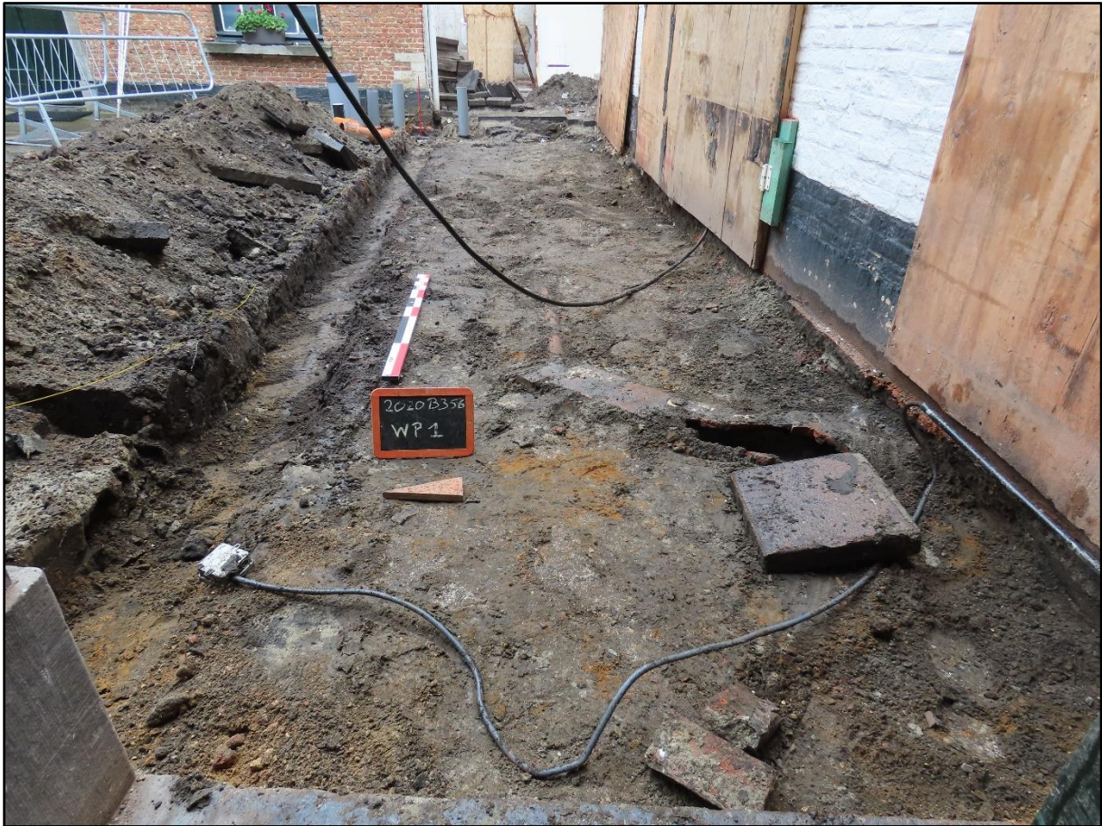
Figuur 35 Zicht op werkput 1 na het uitgraven, gezien vanuit het westen. Op de voorgrond de verstoring veroorzaakt door de nog werkende afvoerleiding. Links op de foto is de iets diepere uitgraving van de funderingssleuf te zien.
