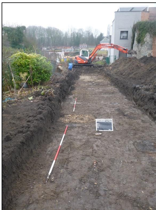
Figuur 7: Aanleg van vlak 1, net onder de bouwvoor met vooral (sub)recente lagen
