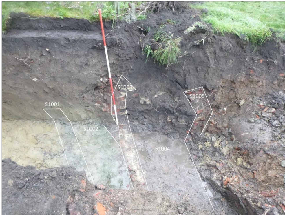
Figuur 10: De 19 de -eeuwse riolering ter hoogte van profiel 2 en betonnen buis net ten zuiden ervan
